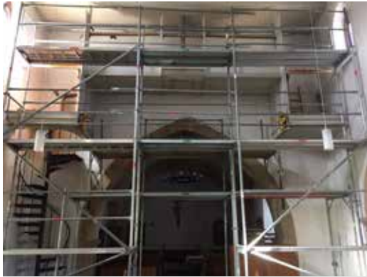
Ein riesiges Gerüst steht in der Vlattener Pfarrkirche. Viele Einzelteile der Orgel sind abtransportiert worden und werden restauriert. Foto: ush
